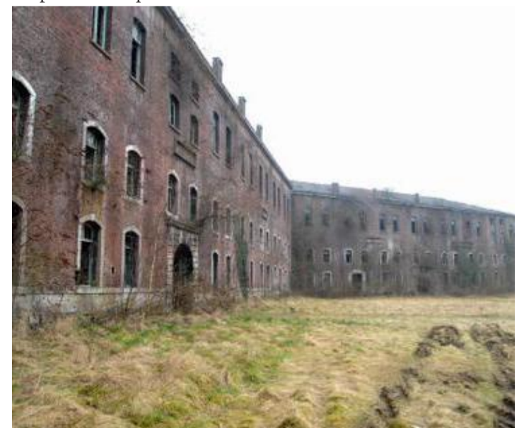
Un site laissé à l'abandon. © D.R.
