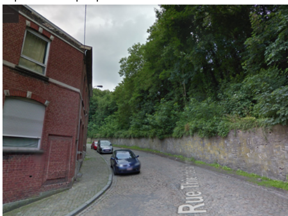
Le Thier de la Chartreuse, côté Cornillon, est une rue pavée en mauvais état et dont le caractère « circulation locale » mériterait d'être accentué.
