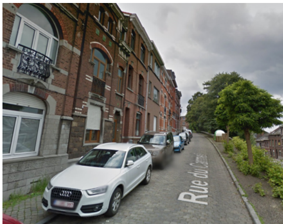
La rue du Carmel est une petite rue pavée en mauvais état, dans laquelle il n'est pas possible de se croiser.
